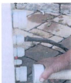
2. Boucher l'orifice du bas avec un bouchon puis, rincer l'intérieur de l'échangeur en insérant un boyau d'arrosage dans l'orifice du haut. Laisser l'eau s'écouler 30 à 45 secondes.
